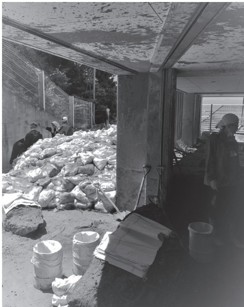
土砂をかき出して袋に詰め、積み上げていく。重機が入れない地形のため人力だけが頼りだ =2018年8月2日、広島県安芸郡坂町
