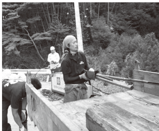
大島でがれき撤去をしている(2011年8月)
