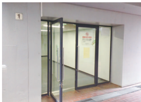
工事予定の3号館1階西側の扉
