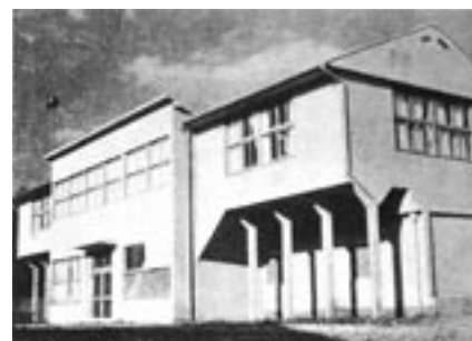
写真3 後楽園校地への文学部・工学部の教養課程移転（1953）、中央大学高等学校・通信教育部の移転（1959）に伴い、図書館分館として新築され、1971年度まで使われた。
