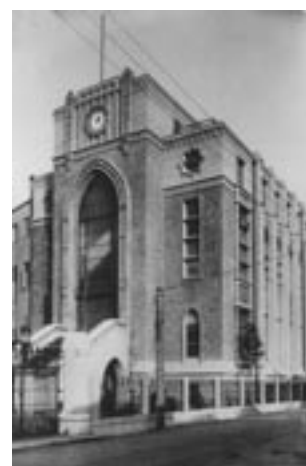
写真2 駿河台移転に伴い、鉄筋4階建、2,765㎡の広さを持つ近代的図書館として完成。1987年の多摩移転まで本館および大学院分室として使われた。
