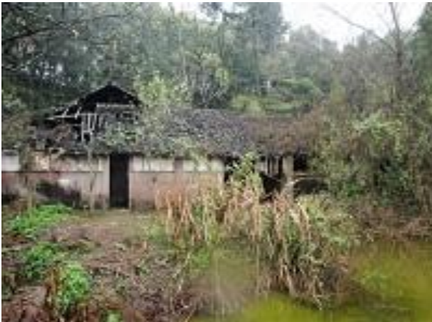
写真 12 重慶・5 村 8 隊（陳氏）四合院西廂房の 煉瓦が落ち、門がなくなり、荒廃した光景が伺える。
