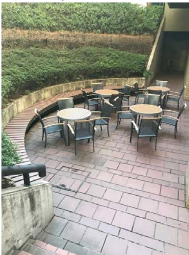
<外構石ベンチ改修工事(後楽園)>
