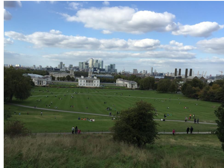
グリニッチからテムズ川の対岸からのCanary Wharfの超高層ビル群
