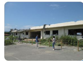
残っている津波の被害
