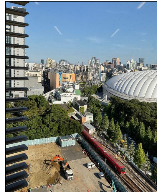
新事務室から望む改修工事の様子
